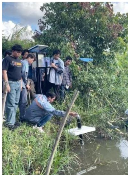
Gambar 4. 24 Pemasangan Alat Monitoring dan Kontrol Kualitas Air Berbasis IoT
