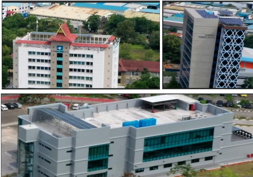
Gambar 4. 1 Instalasi Panel Surya pada Gedung Utama, Tower A dan Technopreneur Centre Politeknik Negeri Batam
