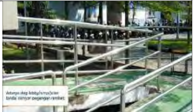
Gedung Tower A
