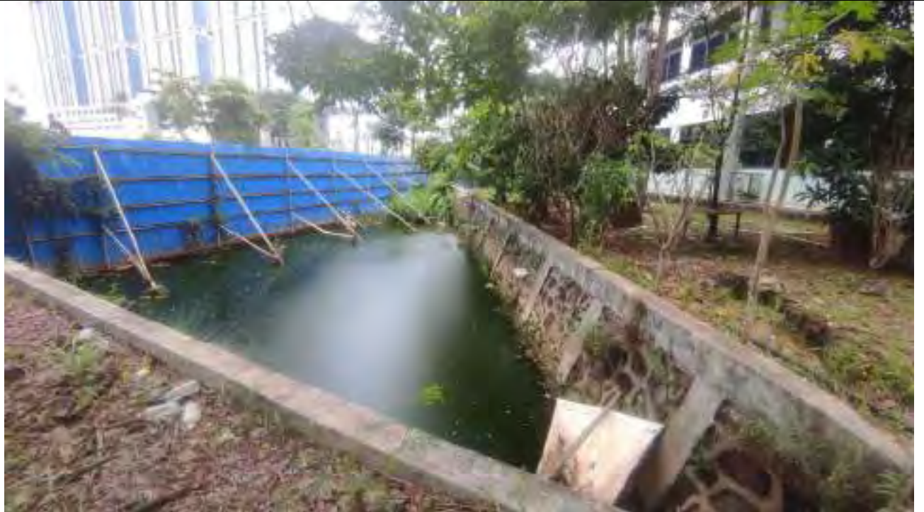
Foto kolam penampungan air (recycling water) Luas area kolam = 414,78 m 2
